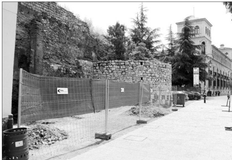
Imagen de la parcela donde comenzaron las excavaciones para edificar. RAMIRO
